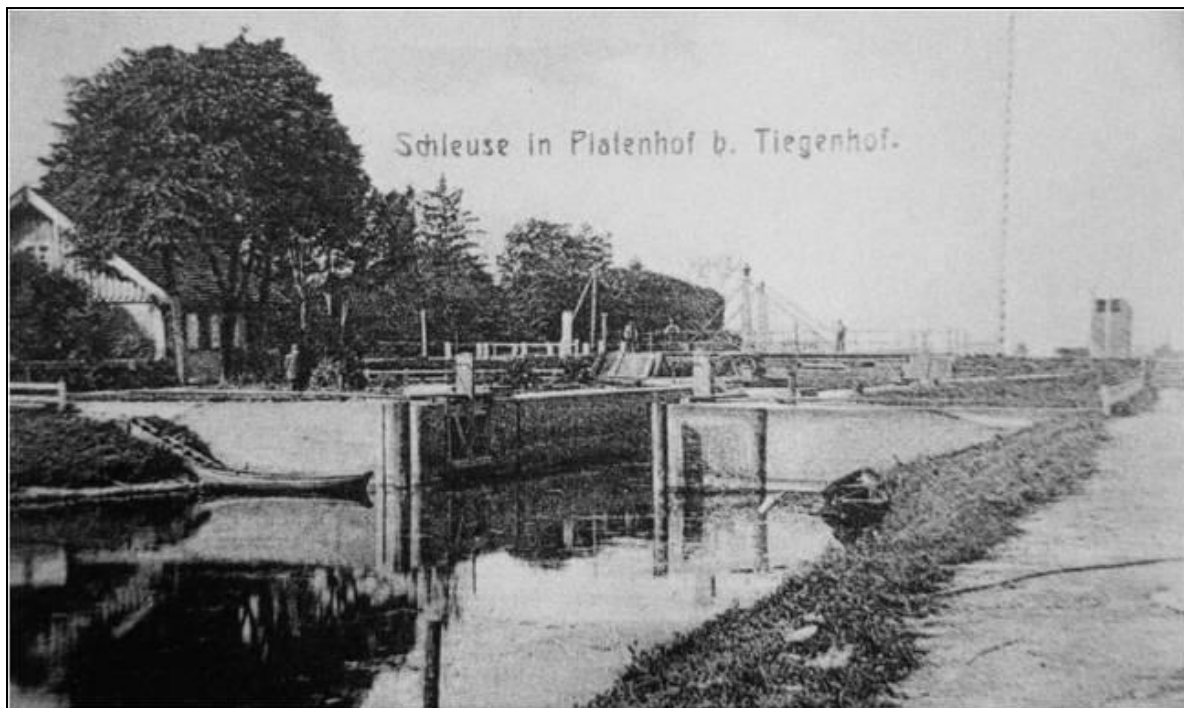
Śluza w Platenhof. Dzięki niej można było pokonać różnicę poziomów pomiędzy Kanalem Wiślano – Zalewowym i Tugą.
